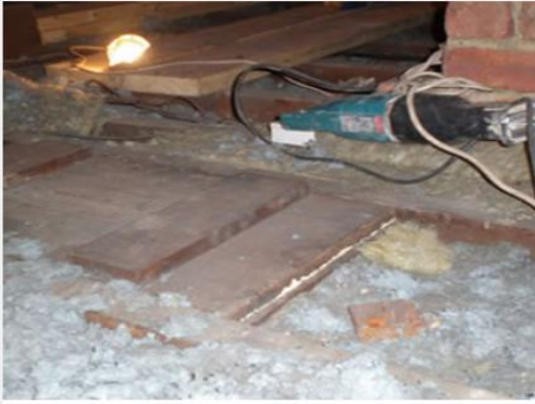
Loose-fill asbestos
