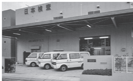
日本検査(株)理化学試験センター
